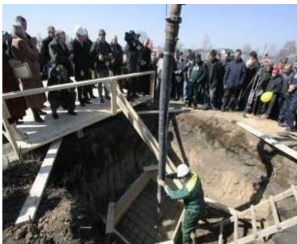
Начало строительства спортивного зала
